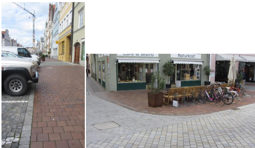
Stadt Landshut, barrierearm umgebaut mit rotem Klinker
